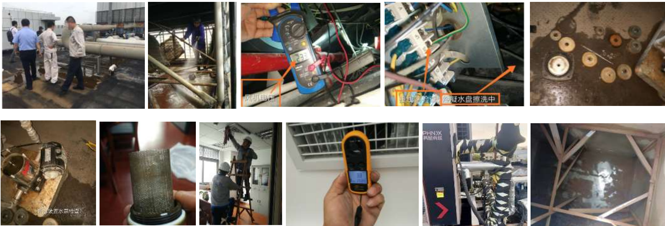
空调冷却塔、水泵、空调末端、热泵热水器、水箱等设备设施检修、维保、清洗现场工作照片
